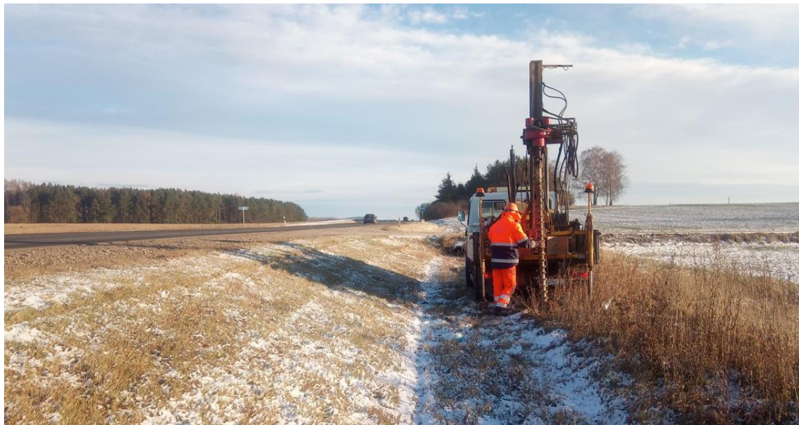
1 pav. Lauko darbai
